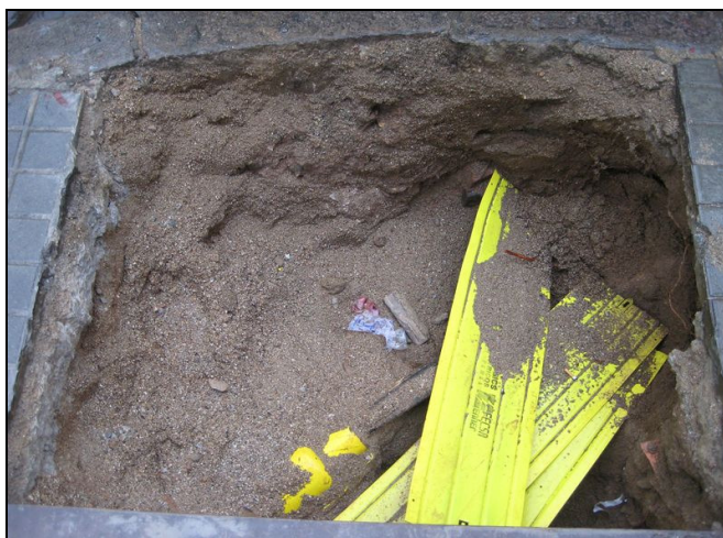
Imatge de l'obertura per l'arqueta del c/Princesa durant el rebaix
