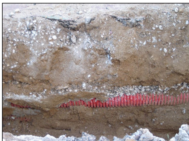
Conducció per cablejat
