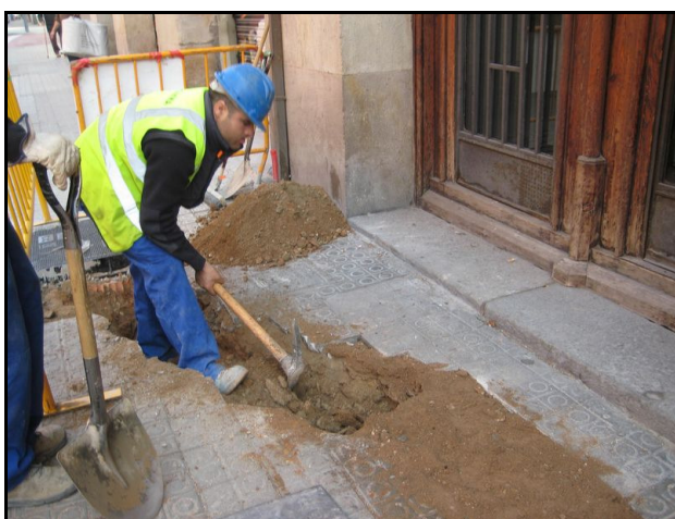
Un obrer buidant la rasa de forma manual
