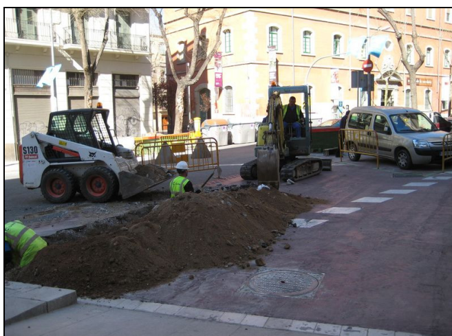
Durant el rebaix del tram de rasa transversal al c/Princesa
