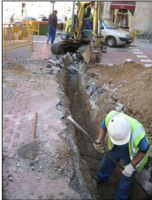
Un treballador dins del tram de rasa del c/Princesa
