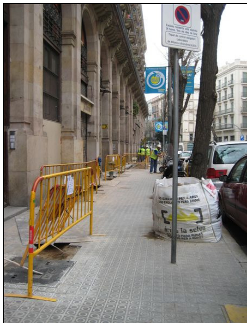
Imatge del llarg de la rasa a la vorera del c/Comerç
